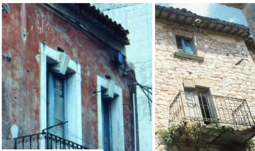
Figura 103. Due esempi di inizio di meccanismi di collasso sismico delle piattabande.
