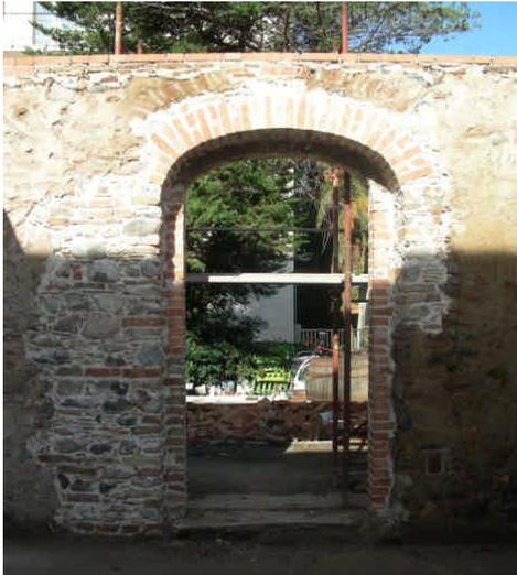
Figura 107. Incatenamento del muro del primo livello e appoggio delle travi del solaio.
