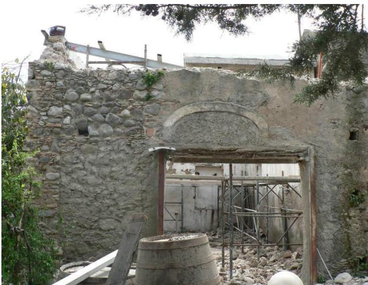
Figura 106. Situazione ante opera del primo livello e realizzazione dello stipite mancante
